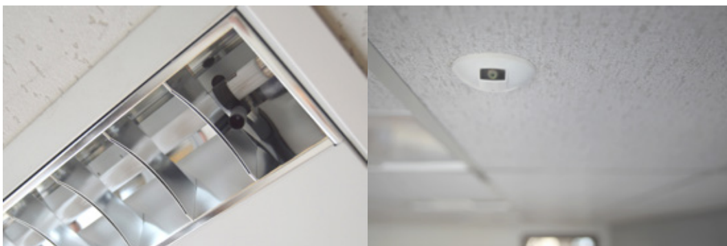
◀ Naar het werkvlak gerichte lichtsensor, bevestigd op de tl-lamp
