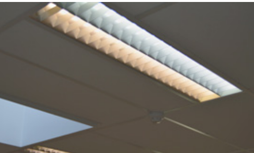
▲ Toepassing van lampen met verschillende kleurtemperatuur binnen dezelfde ruimte of armatuur kan erg storend zijn.
