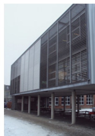
▲ Voorbeeld van een lamellen-systeem: Sint-Ludgardisschool Merksem
