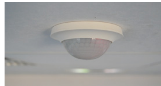
▲ Toepassing van een PIR-bewegingssensor in een aanwezigheidsdetector
