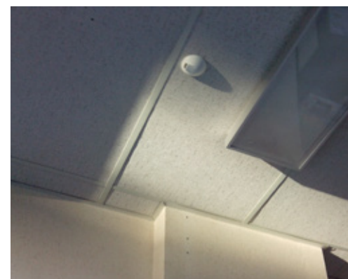
▲ Gerichte lichtreflecties op de sensor veroorzaken irrelevante meting door de sensor
